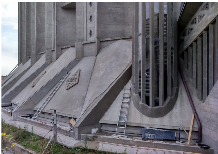
Vue des nouvelles toitures du bas-côté nord
