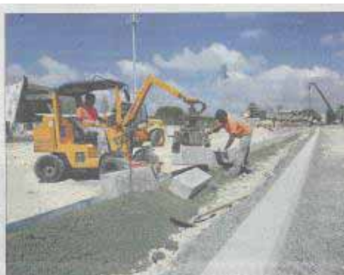
Le chantier du secteur deux, avec l'espace réservé aux taxis et six quais bus supplémentaires, sera terminé en mai. PHOTO AG CARA
