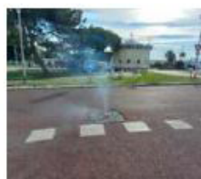
La fumée insufflée dans le réseau d'assainissement ressort par les interstices et permet de mettre en évidence les points critiques. S.O.
