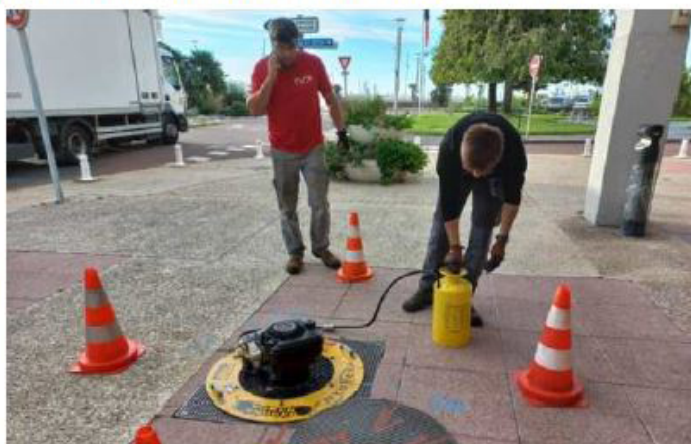
Un moteur thermique permet d'envoyer dans une bouche d'égout de la fumée blanche épaisse, sans odeur et non toxique. S.O.
