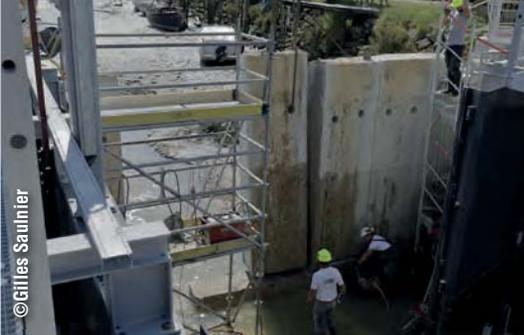
Installation d'une porte busquée de 8 mètres de large et 5 mètres de haut. Celle-ci s'ouvre à marée montante, dès que le niveau d'eau du chenal atteint celui du bassin. Les derniers travaux s'achèvent avant l'été avec la mise en place des pontons et passerelles et la réalisation du quai d'honneur, baptisé le 3 juillet 2022 du nom de l'ancien maire et président de la CARA Jean-Pierre Tallieu.
