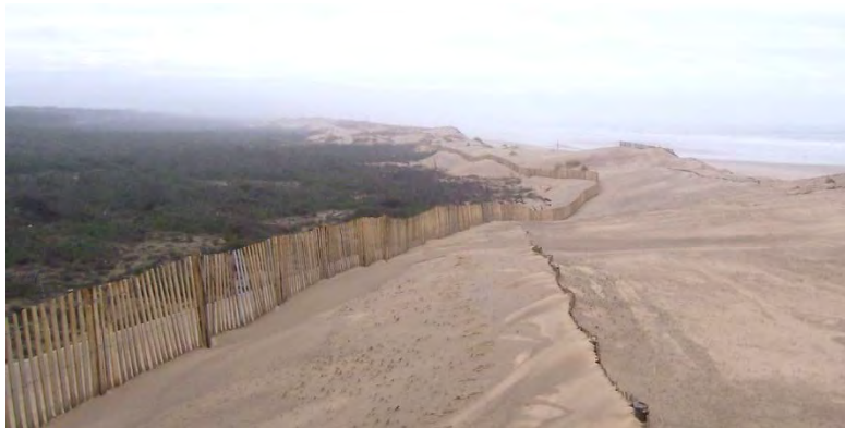
Mise en place de ganivelles
