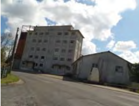
De grands bâtiments parfois désaffectés (Moulin à blé de la Seudre à Mornac-sur-Seudre)/G.HERRY-EVEN CONSEIL
