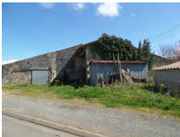
Bâtiments agricoles dégradés /G.HERRY-EVEN CONSEIL
