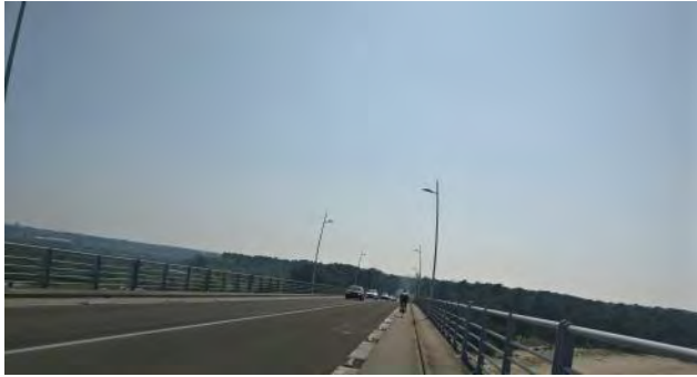
Entrée Nord depuis le pont- La Tremblade/ CARA F. Amand
