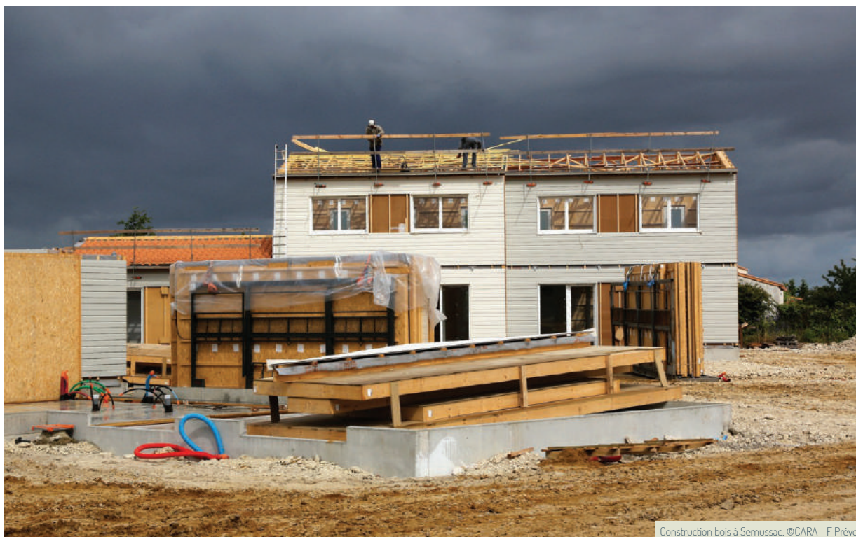
Construction bois à Semussac. ©CARA - F Prével
