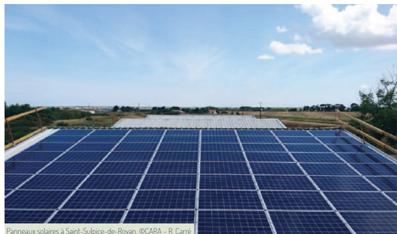
Panneaux solaires à Saint-Sulpice-de-Royan. ©CARA – R. Carré
