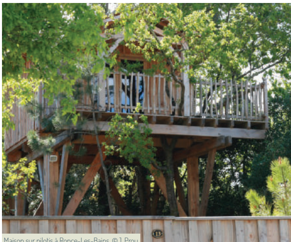
Maison sur pilotis à Ronce-Les-Bains. ©J. Prou
