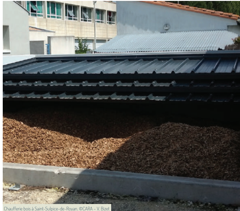
Chaufferie bois à Saint-Sulpice-de-Royan. ©CARA – V. Bizet
