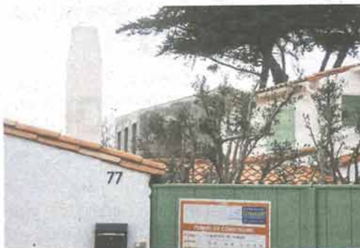
La surélévation est le sujet qui fâche. PHOTO JOCELYNE BARGAIN
