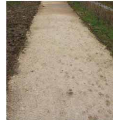
Figure 188 : Revêtement en calcaire
