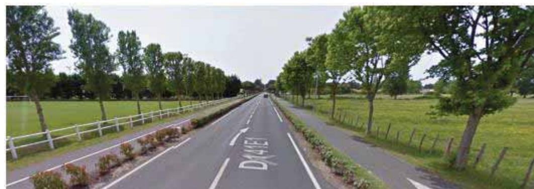
Figure 166 : Site propre le long de la RD141E1
