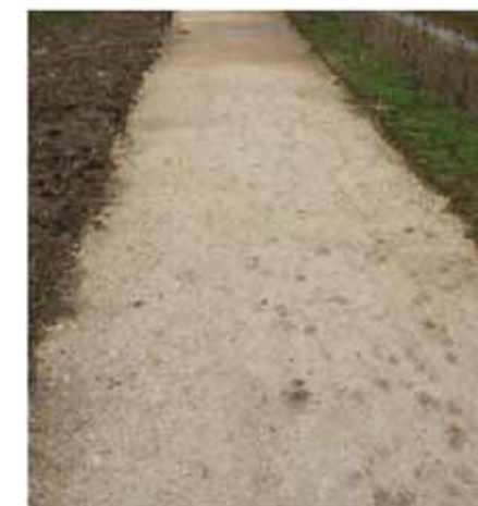
Figure 209 : Revêtement en calcaire
