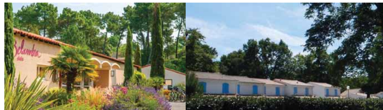
Photo 21 : Bâtiments de camping ayant respectés les codes architecturaux traditionnels ; à gauche : l'accueil du Belambra Club, architecture typique (source : belambra.fr)
