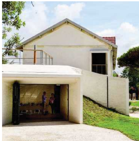
L'extension nouvelle a été réalisée dans le prolongement du bâtiment principal pour accueillir un salon de thé. PHOTO S. HONORÉ
