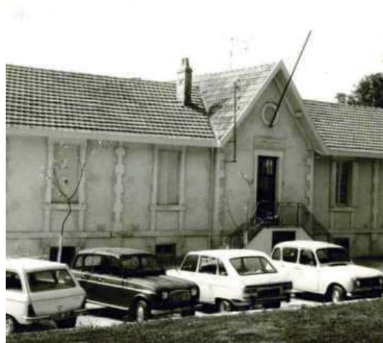
La Maison des douanes en 1976. L'entrée se faisait de l'autre côté du bâtiment. PHOTO MUSÉE NATIONAL DES DOUANES
