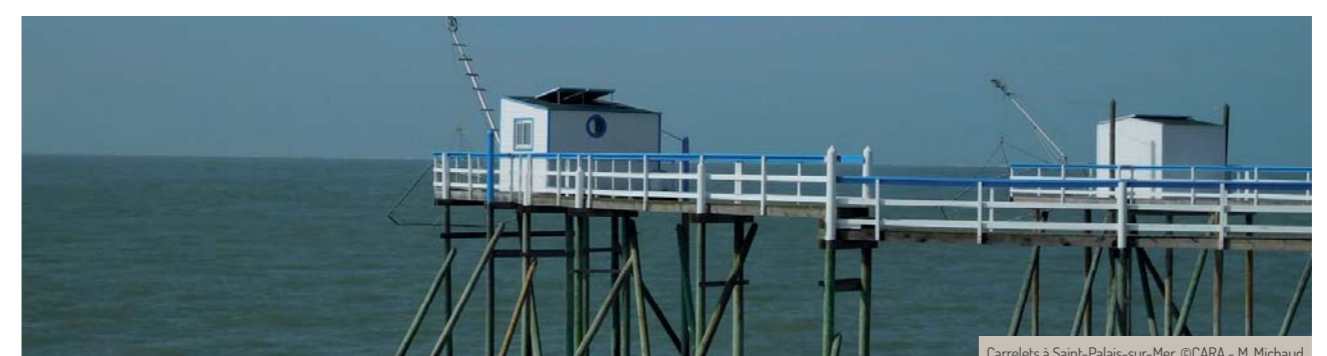
Carrelets à Saint-Palais-sur-Mer. ©CARA - M. Michaud
