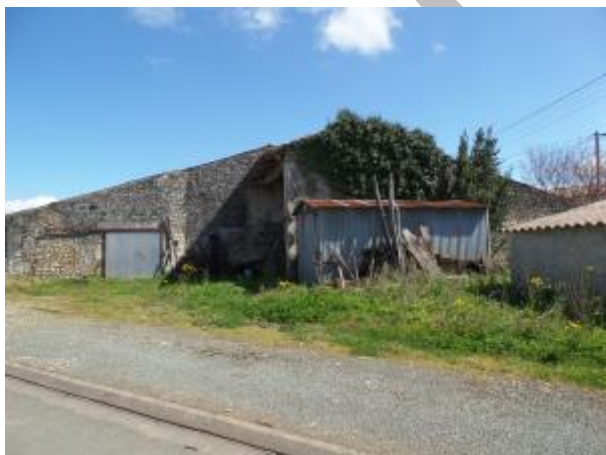
Bâtiments agricoles dégradés /G.HERRY-EVEN CONSEIL
