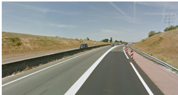
Vues masquées par les talus routiers de part et d'autre de la rocade /GOOGLE MAPS
