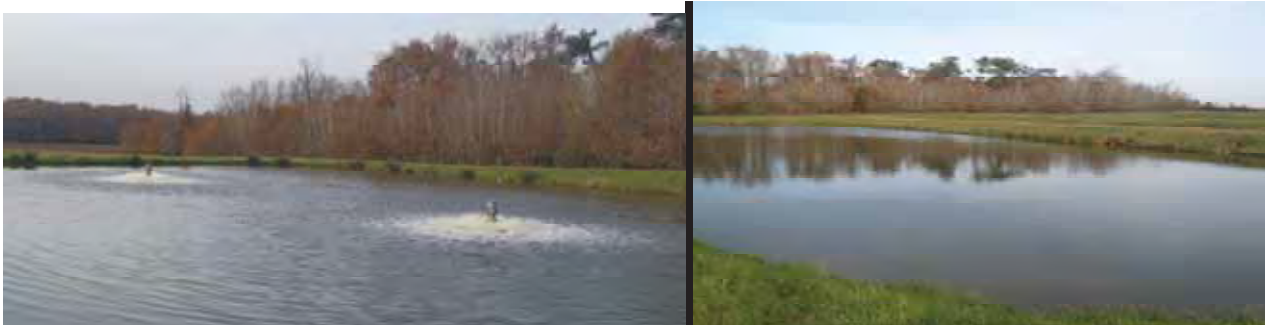
« Le Poteau » -Lagune aérée – 550 EH
