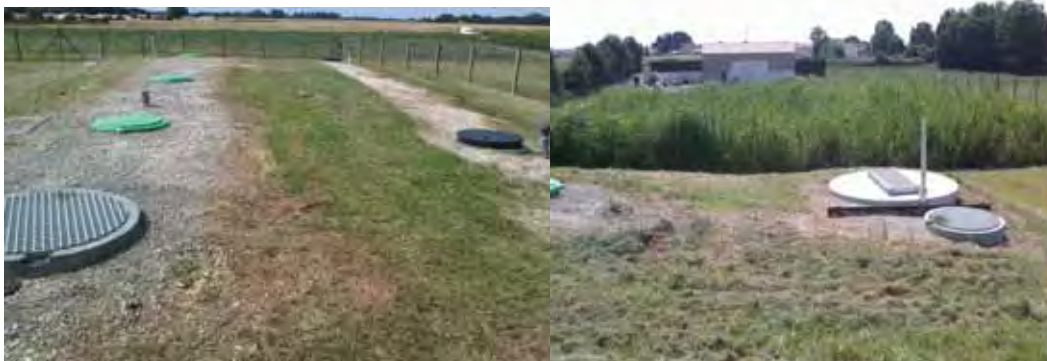
Saint André – Filtres plantés de roseaux – 340 EH
