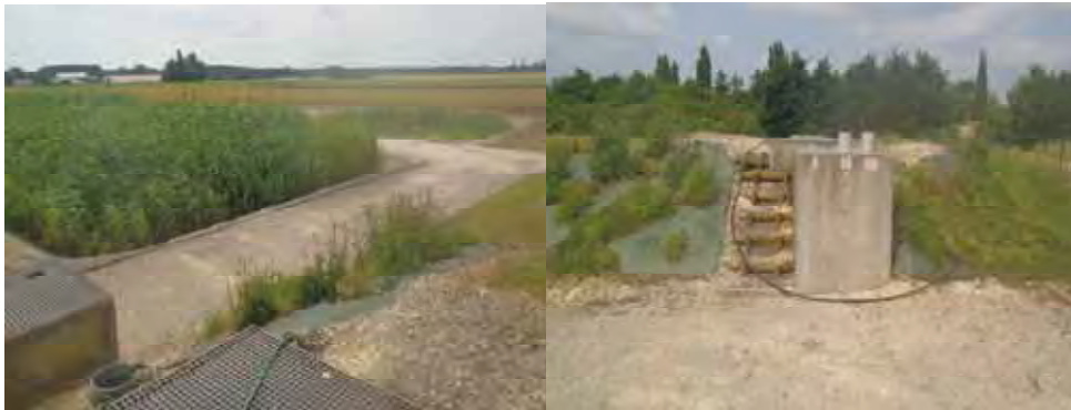
Toulon/Chez Chailloux – Filtres plantés de roseaux – 450 EH
