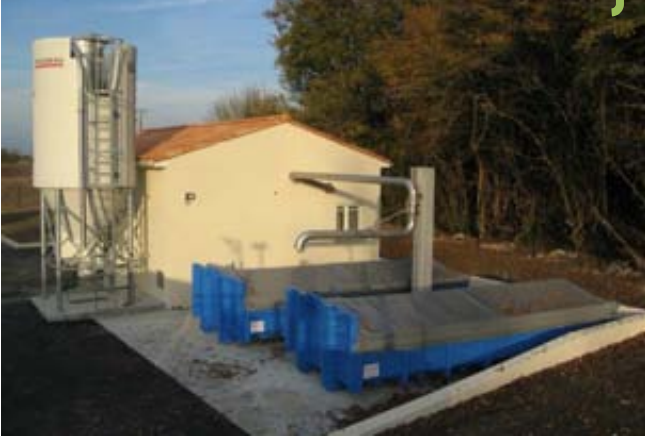
Local déshydratation des boues, bennes de stockage, silo à chaux
