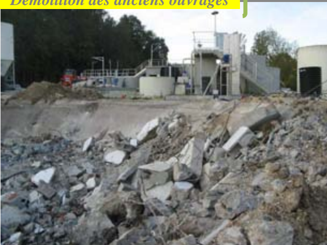
Démolition des anciens ouvrages
