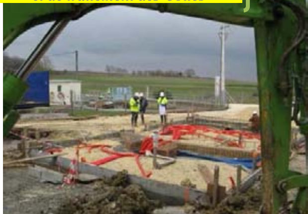
Fondations du local d'exploitation et de traitement des boues
