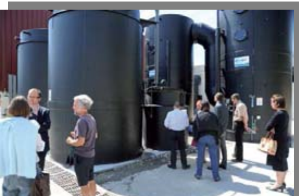
Nouvelle désodorisation des tranches 3 et 4
