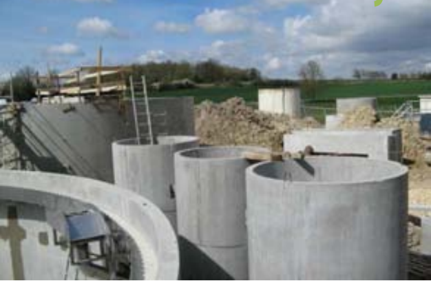
Vue d'ensemble (clarificateur, puits à boues, bassin d'aération...)
