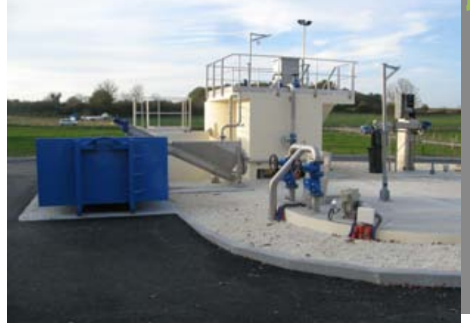
Prétraitements (dégrillage, dessablage, dégraissage)
