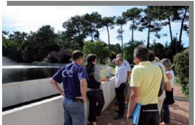
Le cœur de l'épuration avec les bactéries (bassins d'aération), puis la clarification
