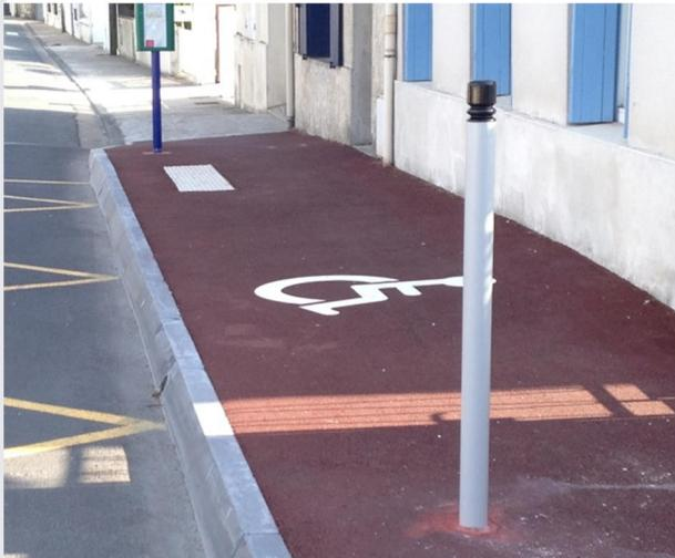
**Le modèle de référence est un potelet thermolaqué en acier galvanisé de 6 à 8 cm de diamètre pour une hauteur hors sol de 1,10 m.**
