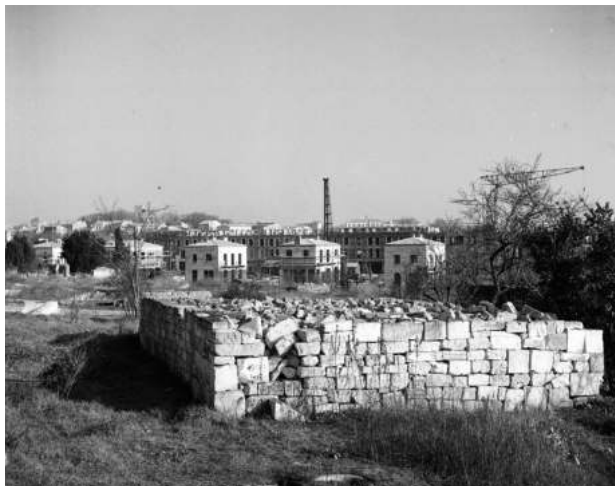
Le boulevard Briand et la rue Pierre Loti en construction Henri Salesse – 1950 - ©Terra
