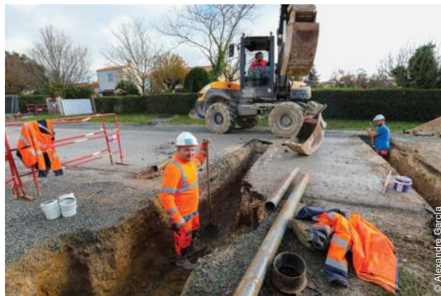
Réhabilitation du réseau d'assainissement collectif, rue de Royan à Meschers-sur-Gironde.
