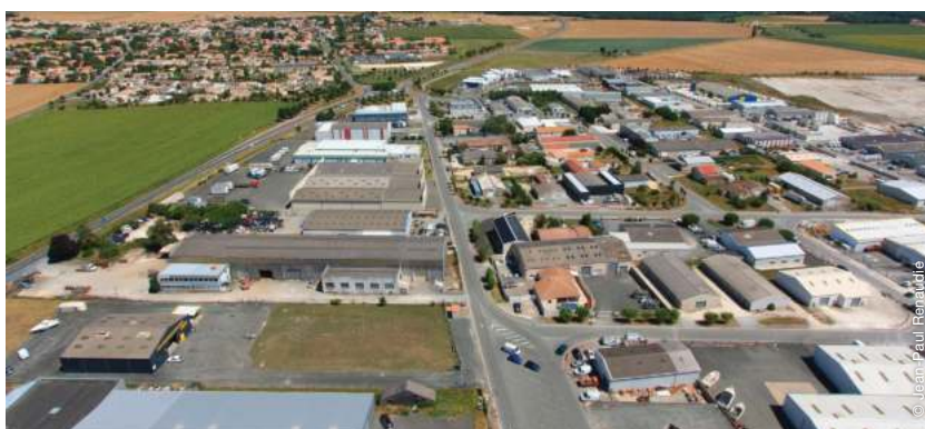
Seules six zones d'activités économiques - existantes ou en projet - auront à terme la possibilité de s'étendre à Cozes-Grézac, Saint-Romain-de-Benet, Saint-Sulpice-de-Royan, Vaux-sur-Mer, Meschers-sur-Gironde et à l'aérodrome Royan-Médus.
