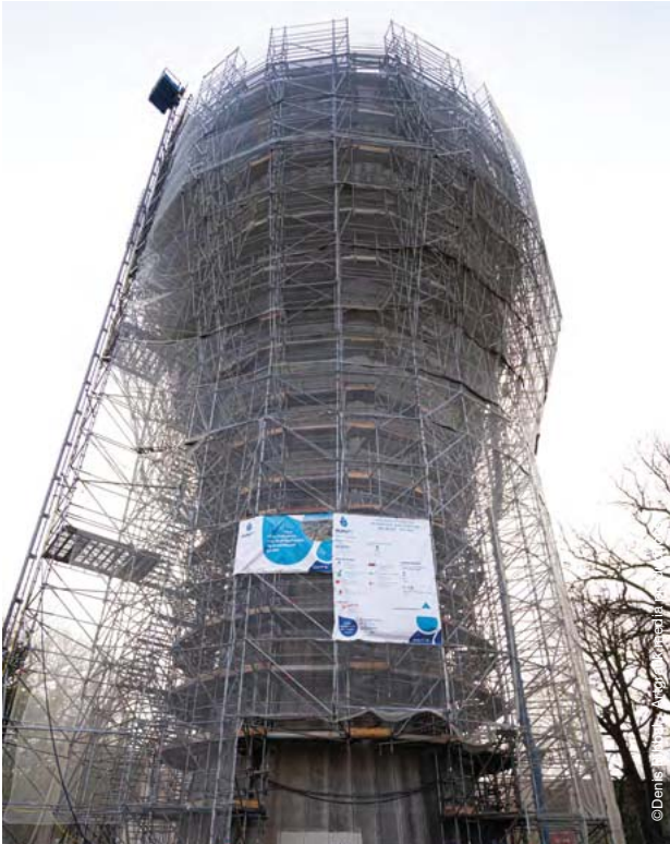
D'importants travaux ont été réalisés en 2022 par Eau 17 pour réhabiliter le château d'eau de Belmont à Royan.
