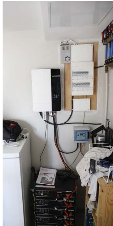
L'électricité solaire arrive dans un boîtier qui redistribue l'énergie dans la maison et les batteries.
