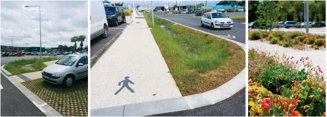
Toutes les alternatives à la pose de canalisations et à l'imperméabilisation des sols sont à privilégier. C'est pourquoi la CARA intègre dans tous ses aménagements des dispositifs facilitant l'infiltration des eaux de pluie, en créant des fossés ou des places de stationnement perméables dans la zone d'activité de la Croix du Bourdon à Saujon, ou encore un jardin de pluie inondable sur le parvis de la gare intermodale de Royan.
