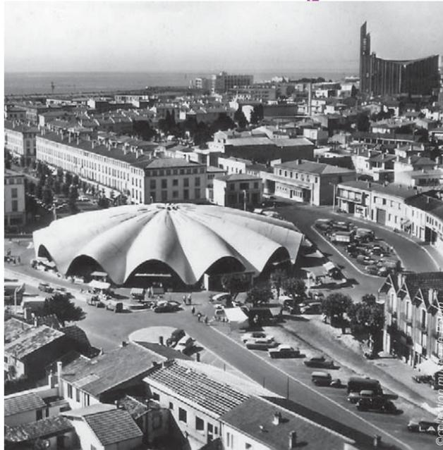
Construit dans le milieu des années 1950, le marché central de Royan fut considéré comme une prouesse architecturale de l'époque. Sa forme de coquillage, d'un diamètre de plus de 50 m sur une hauteur de 10 m, prend appui sur 13 points en partie basse, sans aucun pilier intérieur. Il est classé monument historique en 2002. À l'occasion de son sixtième anniversaire, la ville d'Art et d'Histoire lui consacre une publication, *Laissez-vous conter le marché de Royan*. Informations au 05 46 39 94 45.
