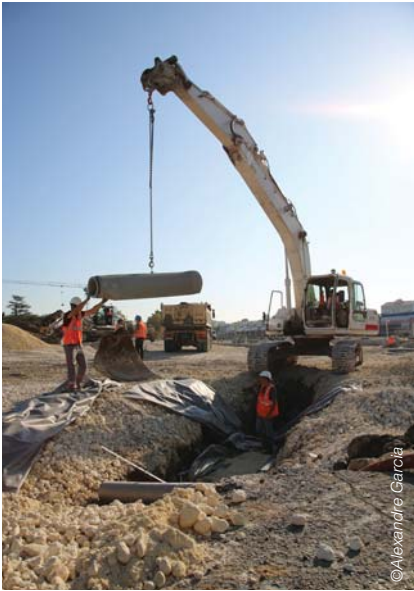
Été 2014 : le chantier commence en sous-sol, avec le renouvellement des canalisations d'eaux usées, puis la construction, au cours de l'automne, d'un immense bassin de rétention des eaux de pluie.
