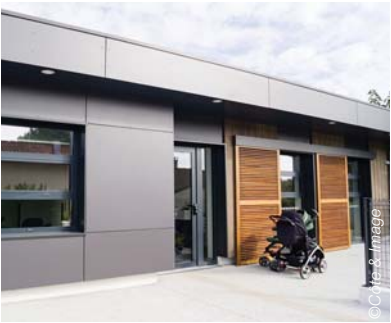
OUEST - Royan Tout près de la Cara, dans une maison d'habitation réhabilitée. 4, rue de la Pitorie
