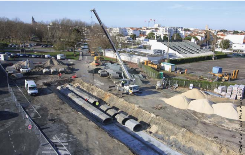
Été 2014 : le chantier commence en sous-sol, avec le renouvellement des canalisations d'eaux usées, puis la construction, au cours de l'automne, d'un immense bassin de rétention des eaux de pluie.
