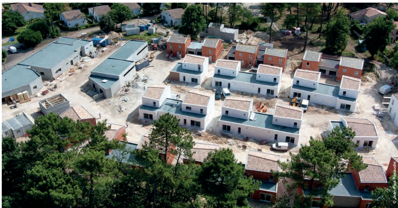
Construction d'un casernement de gendarmerie à La Tremblade
