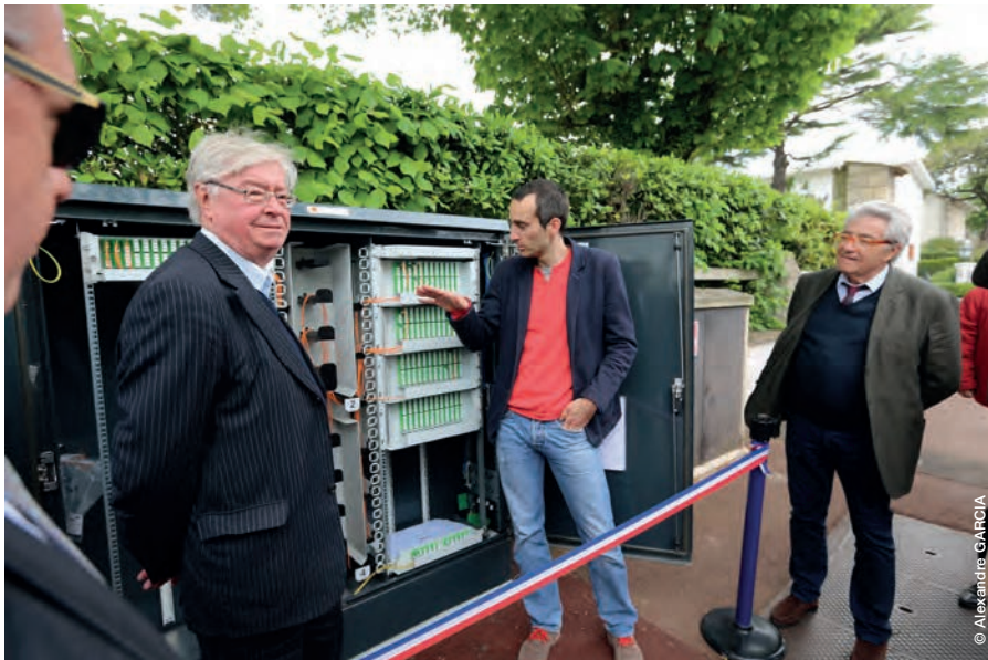
Extension du très haut débit à Royan
