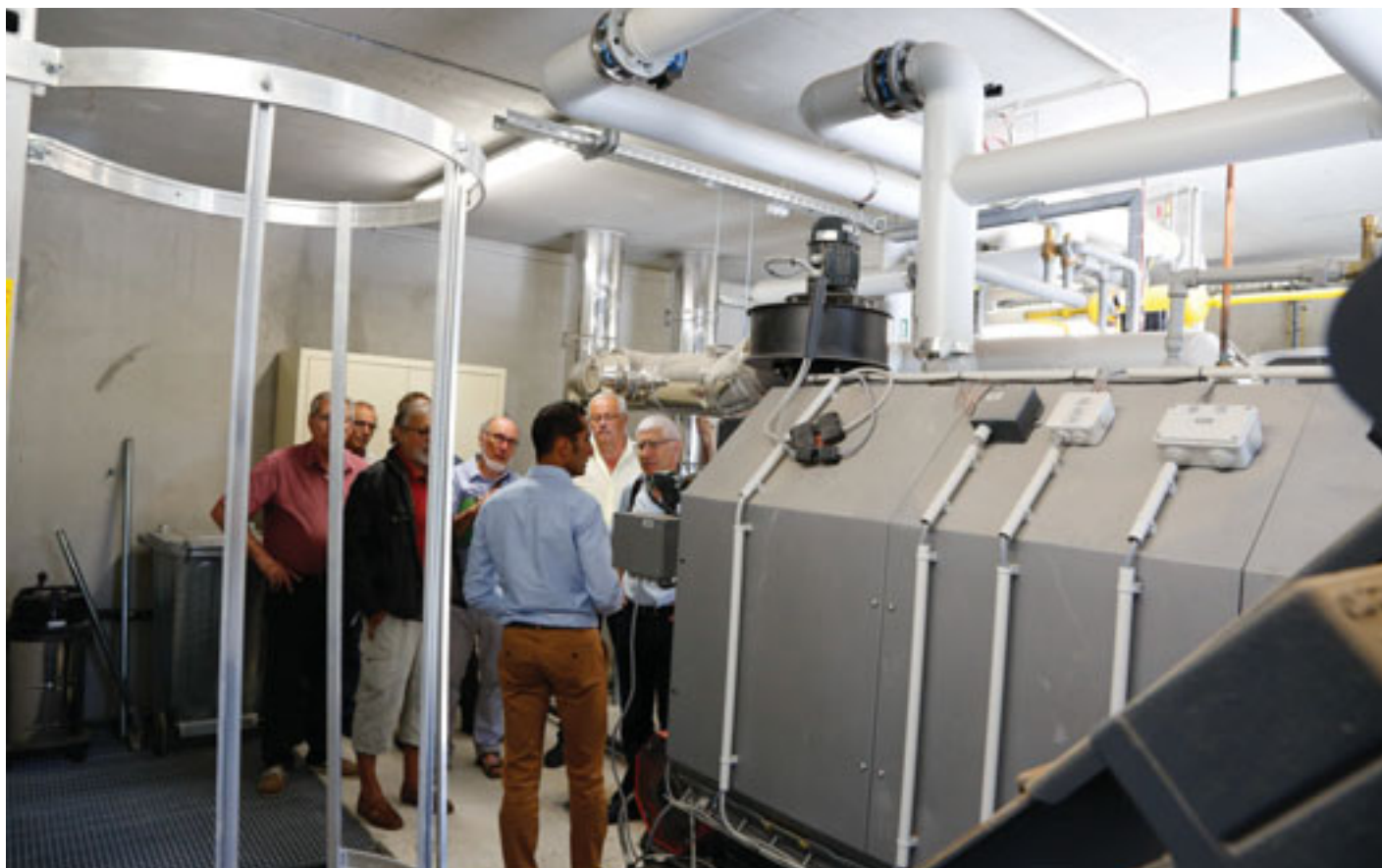
Présentation de la chaufferie bois de Saint-Sulpice-de-Royan
